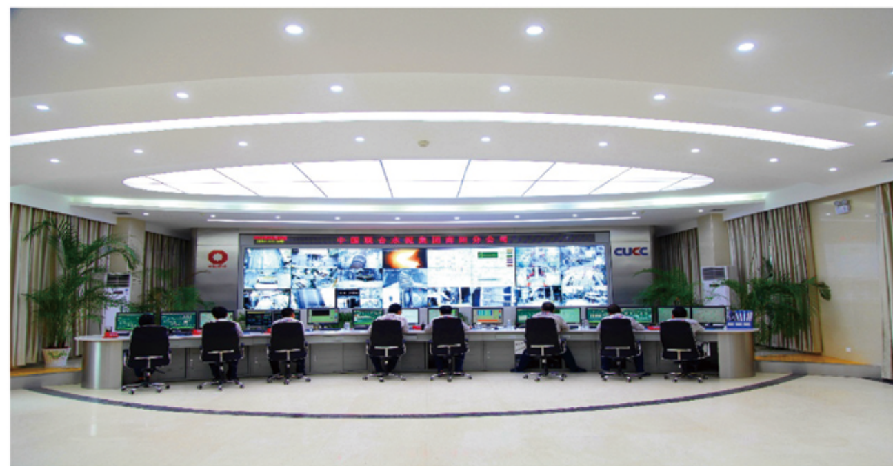
(南阳中联中央控制室)
